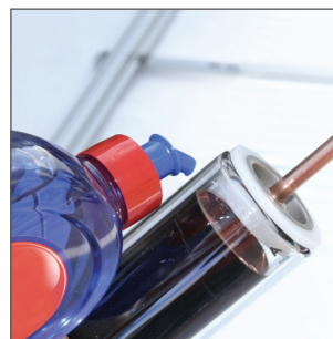
10. Geben Sie etwas Spülmittel auf die Kollektorröhre (Gleitmittel)
